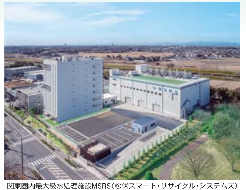
関東圏内最大級水処理施設MSRS(松伏スマート・リサイクル・システムズ)
